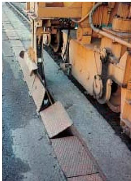
Kiedyś: Metalowe płyty na zawiasach
