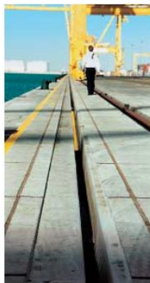
Jebel Ali Port - Dubaj. Istniejąca wcześniej szczelina wykorzystana do instalacji systemu Panzerbelt.
