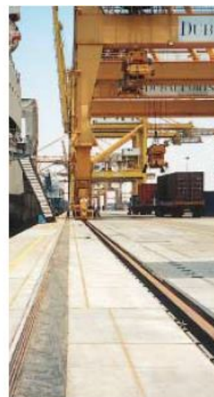
Jebel Ali Port - Dubaj. Zakończona modernizacja instalacji o dł. 1500 m.
